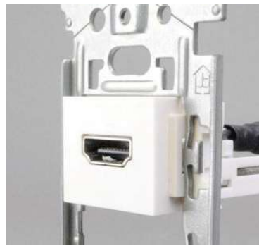
コンセント取付枠への取付
