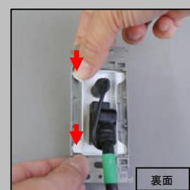
支点にケーブル付きAVコンセントモジュールを差し込んだら、反対側を押し込みます。
