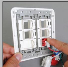
スナップイン中継ケーブルの上側のツメを押し下げるようにしながら、コンセント取付ガイドチップへ押込みます。
