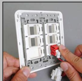
最下部のコンセント取付ガイドチップに下側のツメを引っ掛けるようにスナップイン中継ケーブルを差します。
