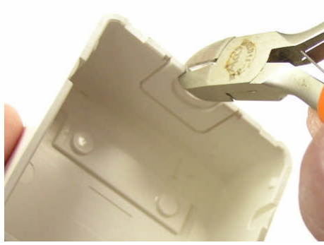
10.ケーブルの径に合わせて引き込み口を割り取ります。
