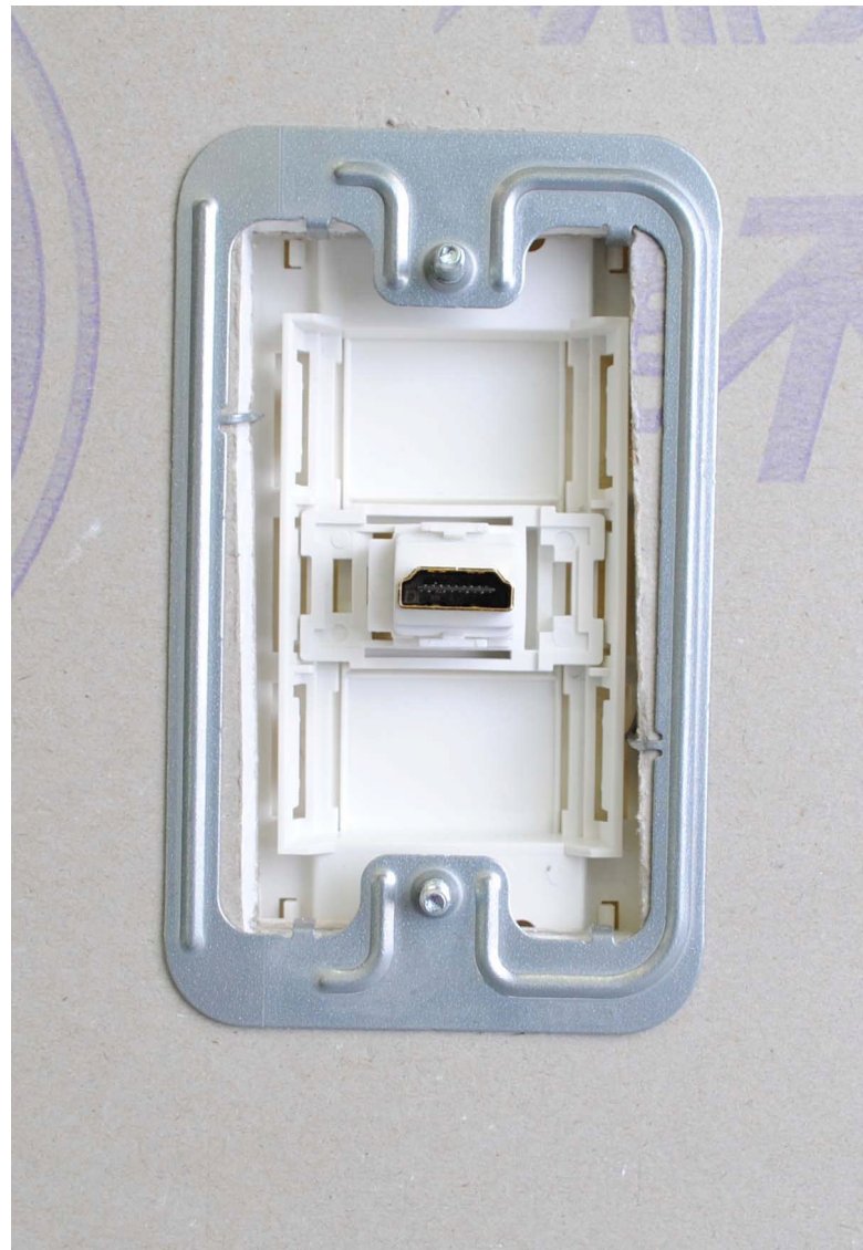
スナップイン中継コネクタの取付例 (裏面)
