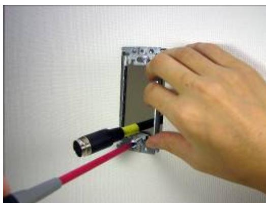
5. AV コンセントの位置を調節してネジを本締めします。
