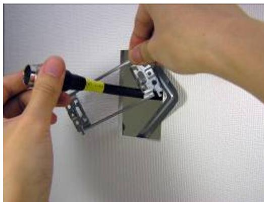
4. はさみ金具の下側のネジ穴と、壁面取付金具の穴をうまく合わせ(画像後送)、附属のネジを入れて仮止めします。
